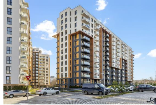
Parcului 2 Bucharest completion in 1H2023 220 units
